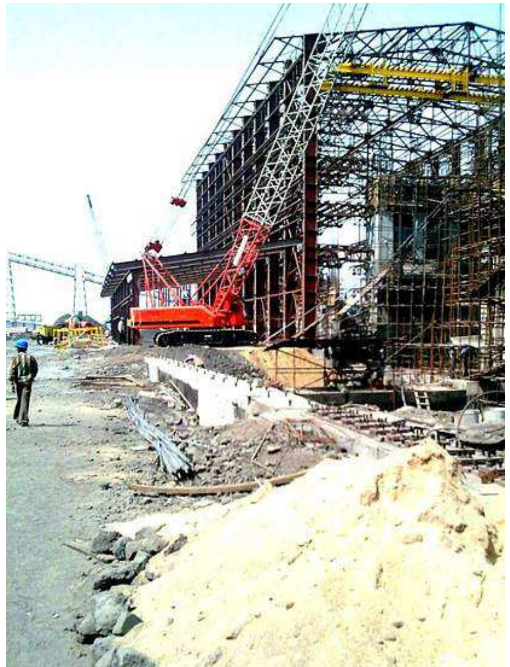
Металлургический завод IISCO (Бурнпур, Индия) Строительная площадка коксовой батареи №11
