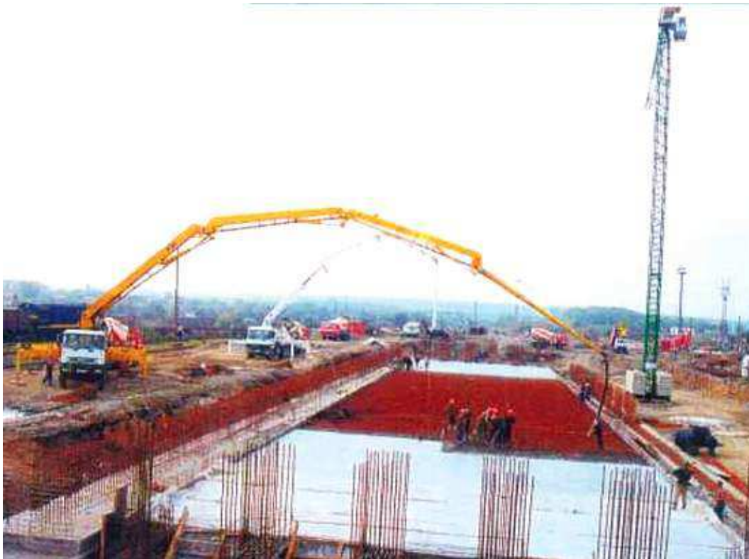
Металлургический завод IISCO (Бурнпур, Индия) Заливка фундамента на площадке УСТК
