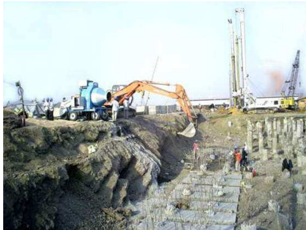
Роуркельский метзавод (Индия). Производство фундаментных работ на площадке УСТК для коксовой батареи №6
