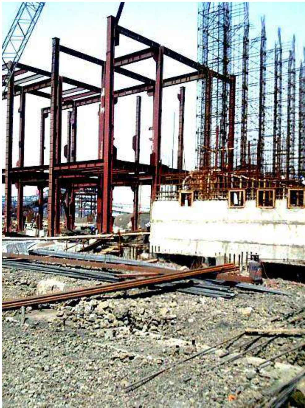
Металлургический завод IISCO (Бурнпур, Индия) Строительная площадка коксовой батареи №11
